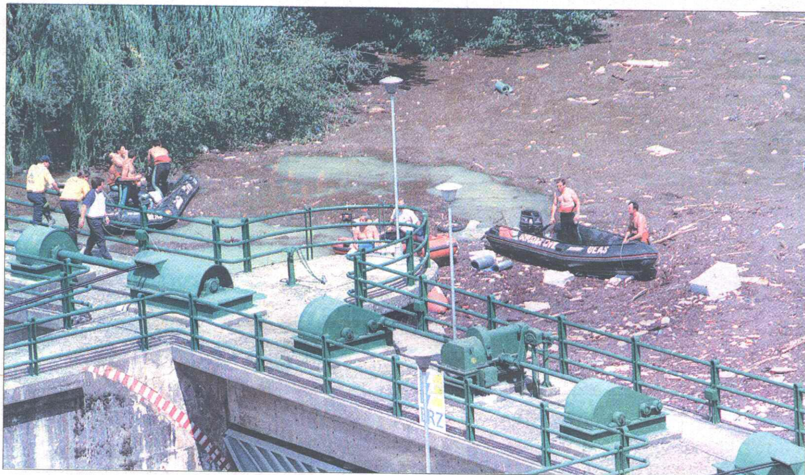
Equipos de rescate buscan desde lanchas neumáticas entre el barro y los restos de enseres, procedentes del camping, acumulados en la presa de Sabiñánigo.
